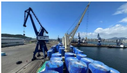
土耳其ERDEMIR焦炉项目
