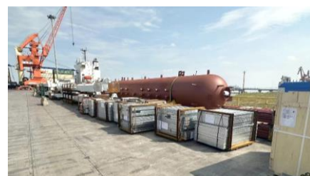
上海电气马来西亚雪兰莪垃圾电站项目
